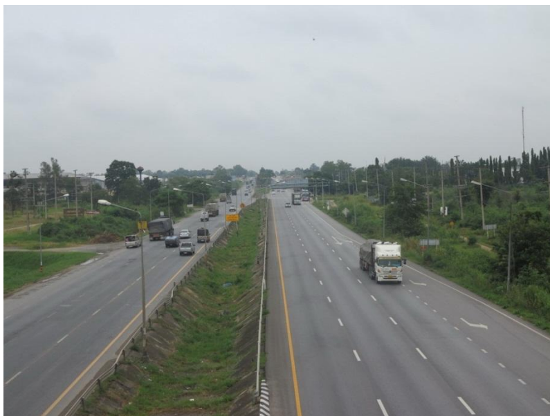
ถนนมิตรภาพสายใหม่(เชียงใหม่)ในปัจจุบัน ระยะจากเสาไฟฟ้าด้านซ้ายถึงด้านขวา กว้างรวม ๘๕ เมตร
